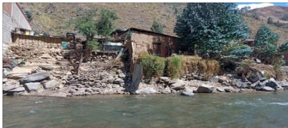
FIGURA N°01: Vista del Río Huallaga con un caudal considerable que amenaza una vivienda o estructura construida peligrosamente cerca de la ribera. Se observa un muro de contención precario y erosión en la base del talud.
