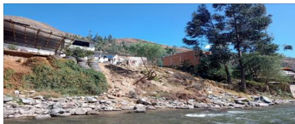
FIGURA N°03: Panorámica del Río Huallaga mostrando una severa erosión de la margen izquierda, que ha socavado el terreno y ha dejado expuestas las bases de una estructura adyacente. El lecho del río presenta material rocoso.
